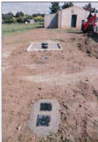
Il y a quelques années, après une inspection vétérinaire sur le site de la fourrière animale, des travaux ont été réalisés au niveau des cages extérieures du chenil. Une dalle de béton armée avec un caniveau intégré est venue habiller le sol pour assurer une bonne isolation thermique et un meilleur écoulement du flux et des déjections vers une tranchée extérieure.
